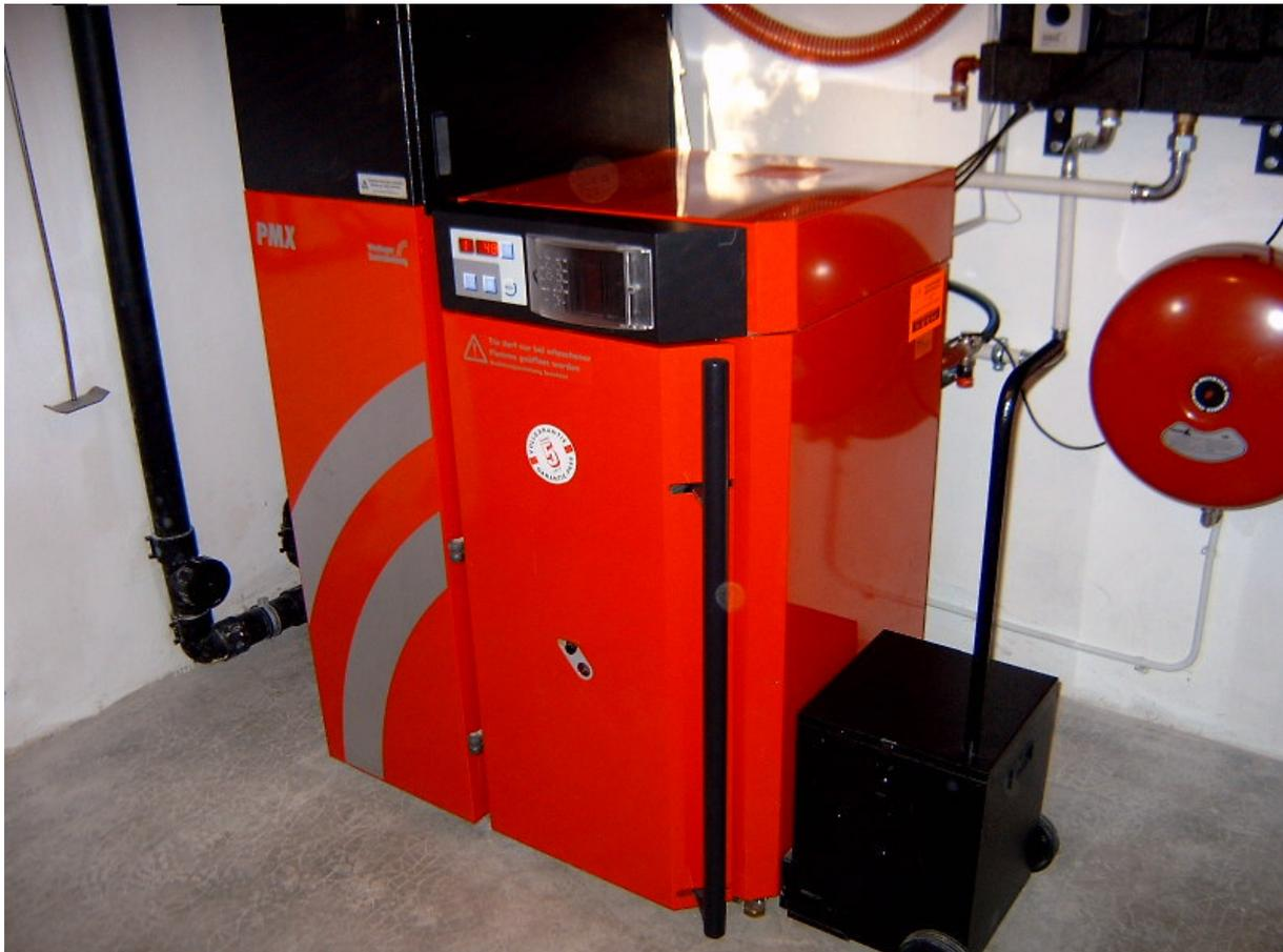
L'ensemble se compose du boiler (sur la gauche), de la chaudière avec son réservoir journalier et le bloc d'aspiration (au dessus) qui draine les pellets du local de stockage jusqu'au réservoir journalier.
