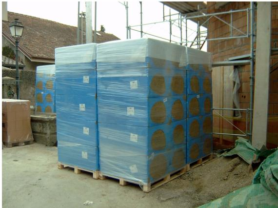
Panneaux de laine de roche pour une isolation de toiture.
